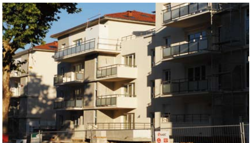
Été 2007 : travaux de façade en cours de finition
