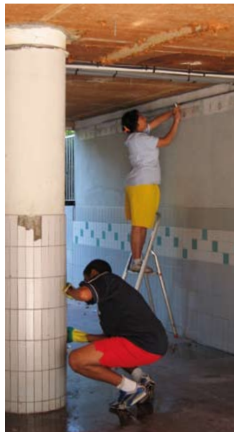
Un chantier à la Sauvegarde
